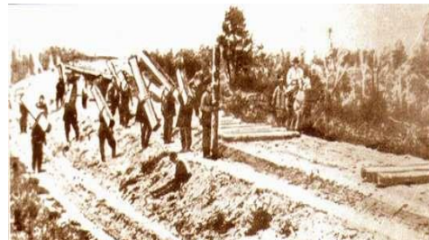
строительство магистрали, укладка шпал
